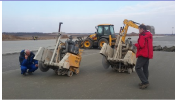
图 2 直径为 500 毫米的切割片在机场路面高强混凝土热胀缩缝施工试验。
