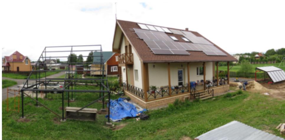
图2 带有太阳能板和太阳能集热器的节能房屋以及正在建设之中电动汽车车棚和季节性蓄热器
